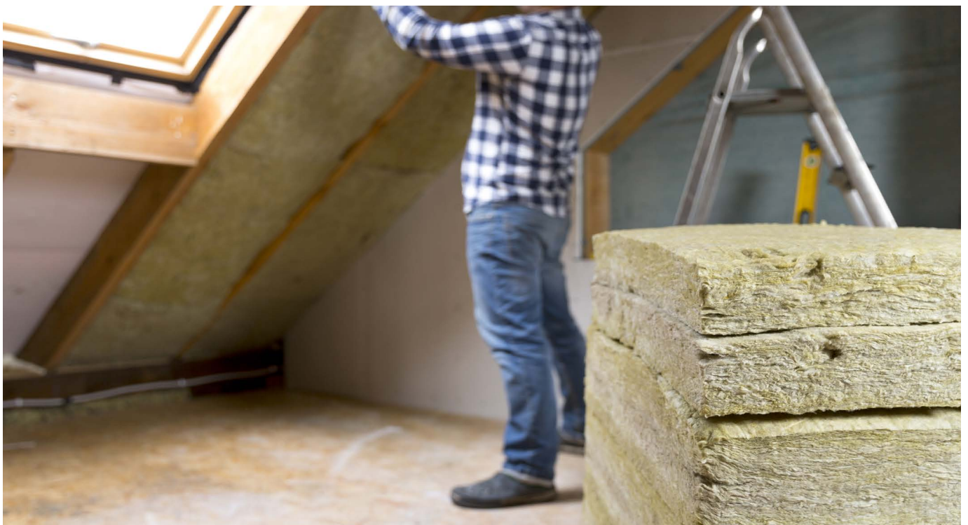
Abb. 11: Mineralwolle – ein universeller und dennoch hocheffizienter Wärmedämmstoff. Er ist leicht, gut verarbeitbar und unbrennbar.
